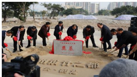
开工动员大会 Construction Launch Ceremony
