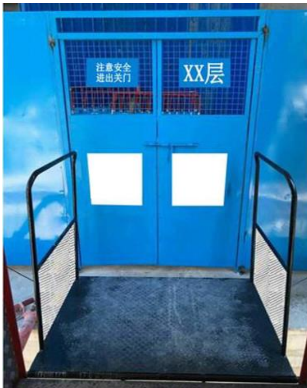
电梯防护门实景图
