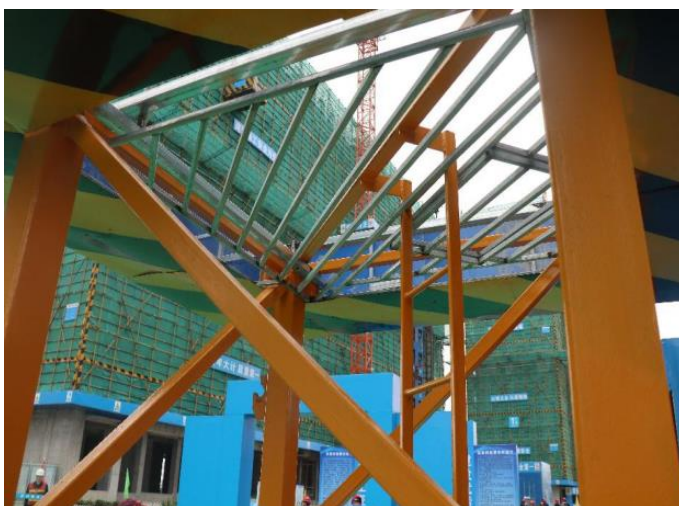
塔吊防攀爬装置
