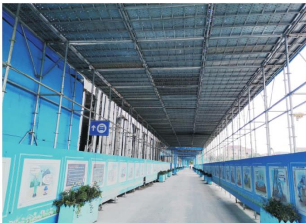
盘扣式脚手架防护通道
