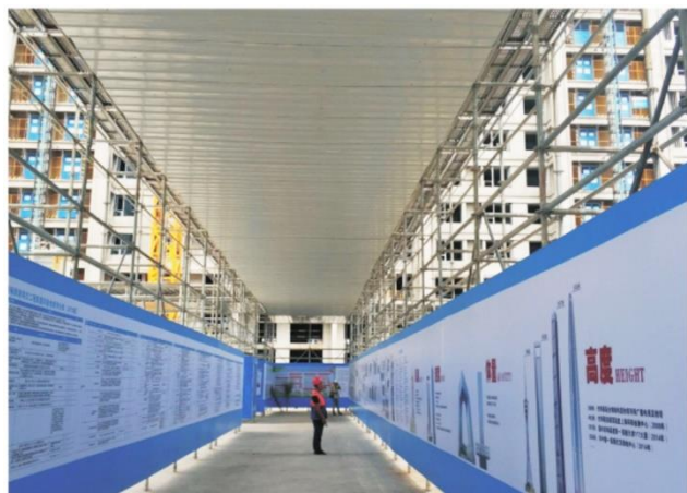
盘扣式脚手架防护通道
