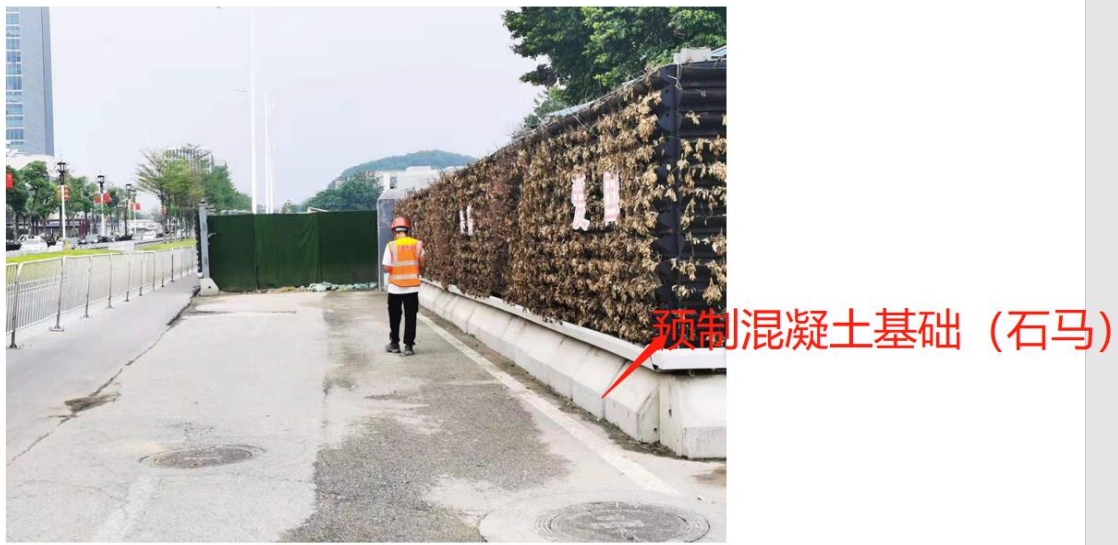
图3 连续围蔽预制混凝土基础(石马)
