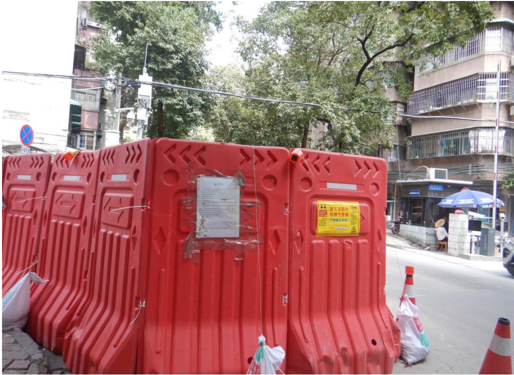
图 6 施工告示及燃气管道告知
