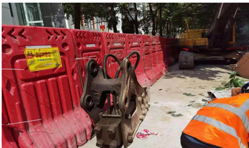
图5 事发时施工现场围蔽
