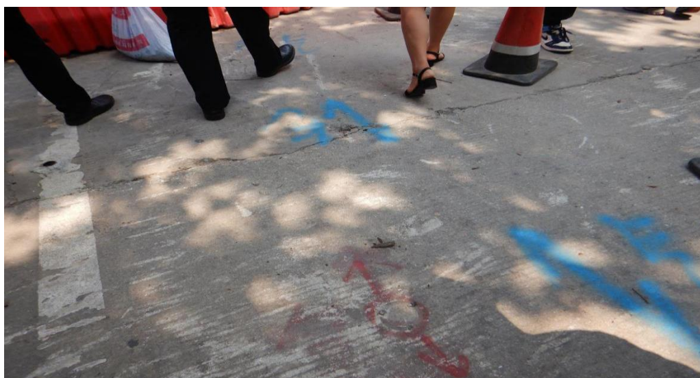
图4 管道地面标识及警戒线
