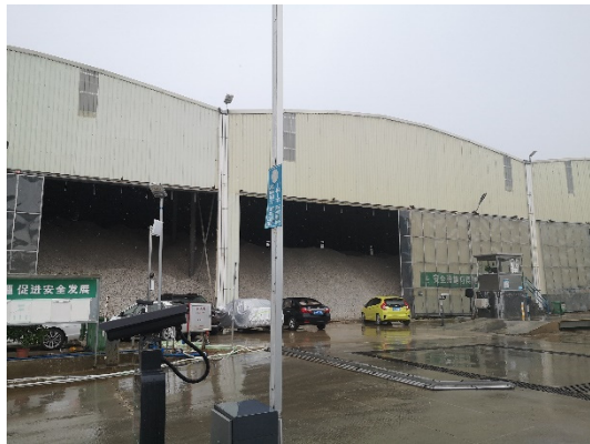
图 8-6 综合利用厂成品堆放区
