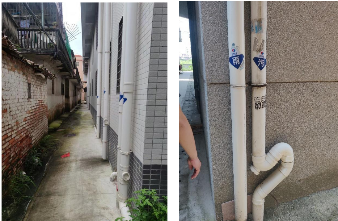
图 4-1 雨污分流装置
