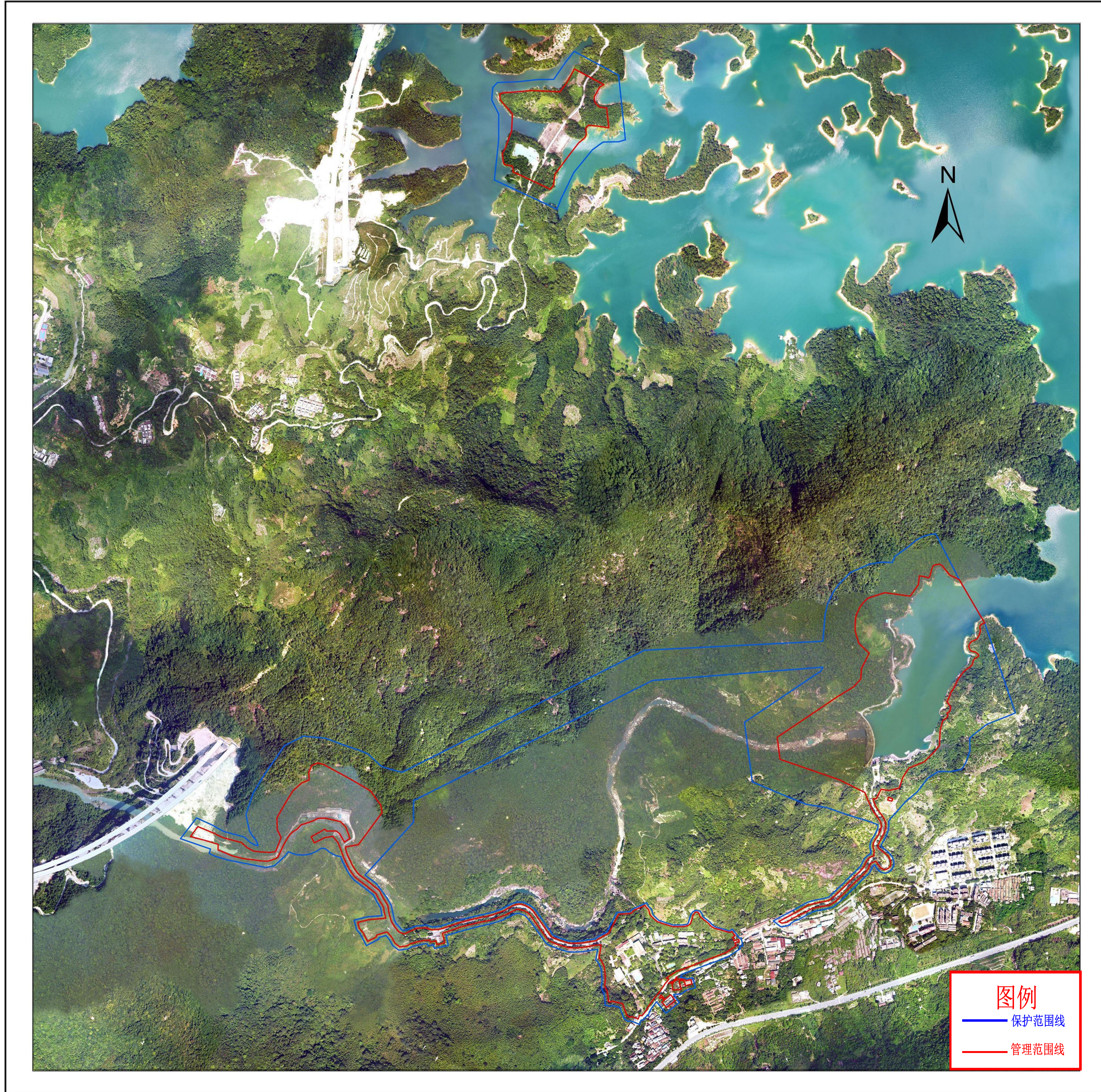
广东粤电流溪河发电有限责任公司水利工程管理与保护范围总平面图
