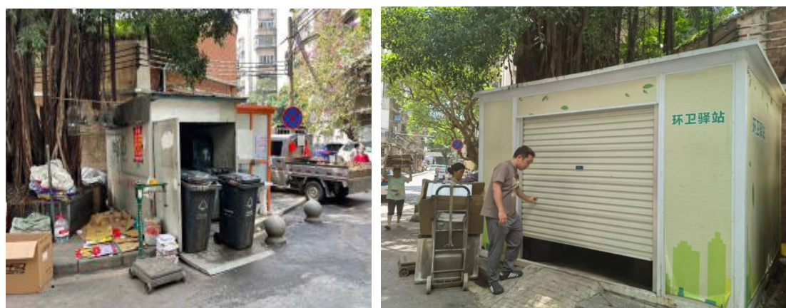
图 6-3 海珠区龙凤街道垃圾收运点升级改造前后对比照片
